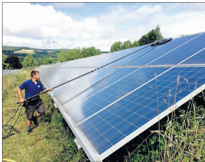
Zur Wartung der PV-Anlage gehört auch die Reinigung.
