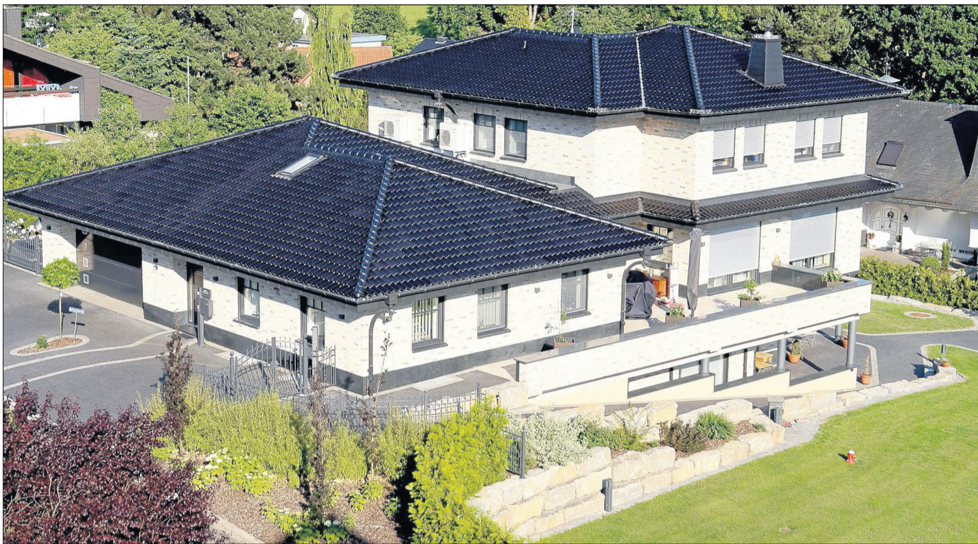
Dachdeckerfachbetrieb am Standort Niederaula.
